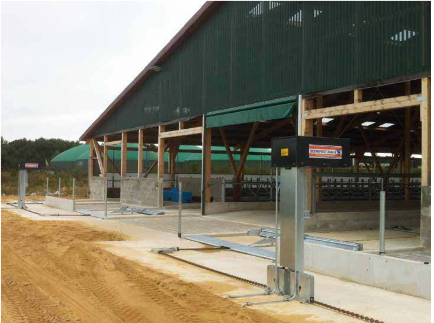
■ Aandrijfstations en afstorten voorzien van afstortkleppen uit plaat met traanprofiel, buiten de stal geplaatst
