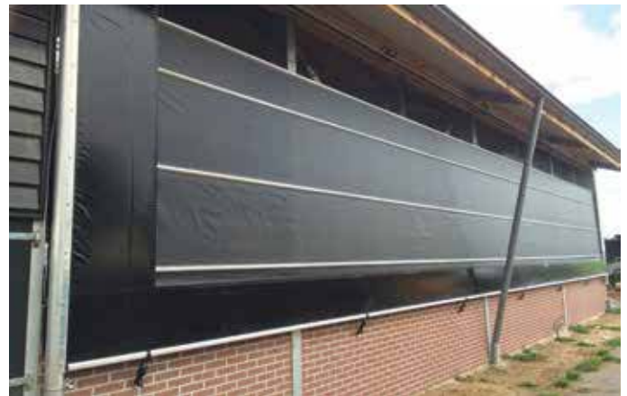
■ BP Segmentsysteem naar onder openend
