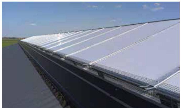
■ Zadeldak-nok met klepsysteem voor regelbare nokventilatie
